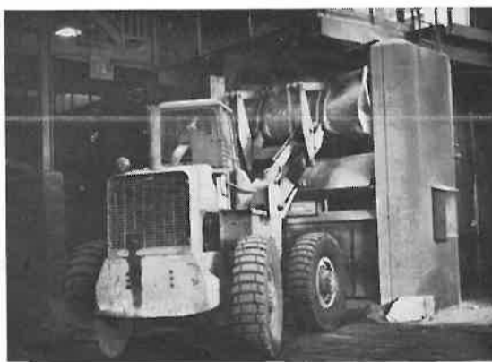
Een payloader stort erts in de bascule
