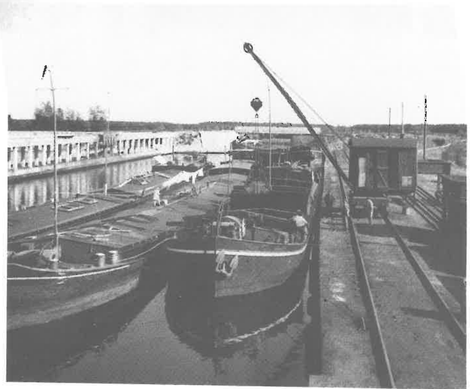
De haven van de Zinkfabriek, "De machinist geeft de kraan en grijper geen rust".
