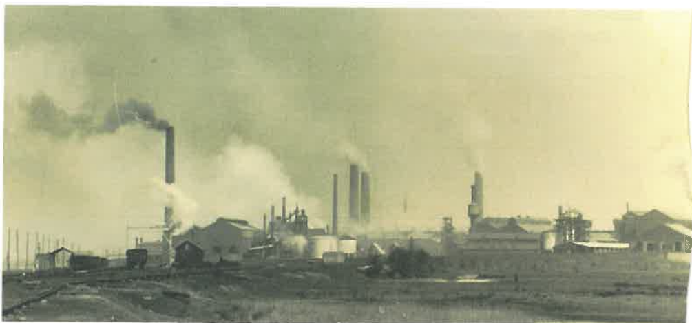
Zinkfabrieken gezien vanaf het kanaal datering ca 1950 van links naar rechts
